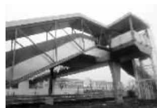
天桥上下客处有楼梯、扶手电梯和垂直升降梯
