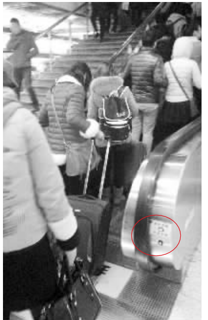
遇到紧急情况,按下“停止”按钮将扶梯停下来 现代快报记者 马薇薇 摄
