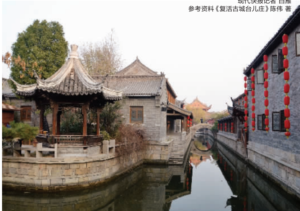
原址复建的岭南风格建筑
