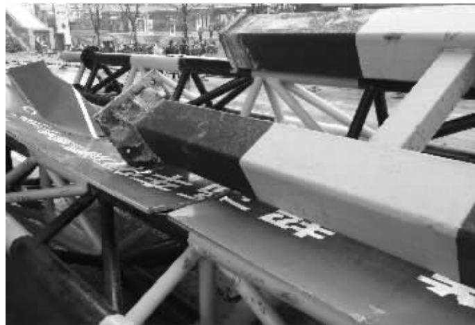
被撞得“支离破碎”的限高架 现代快报见习记者 廖健伟 摄
