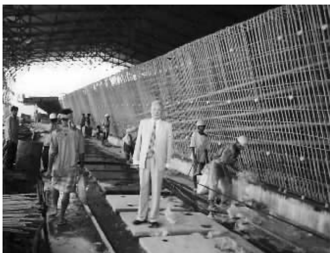
在印度孟买近郊桥梁工地钢筋厂
