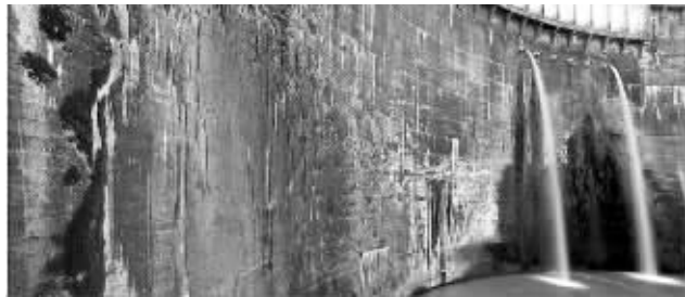
美国加州圣克莱门特大坝
