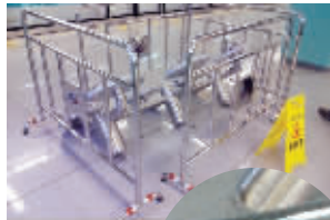
山塘街站内倒塌的座椅。小图显示倒塌座椅底部螺丝露在外面 灵通摄
