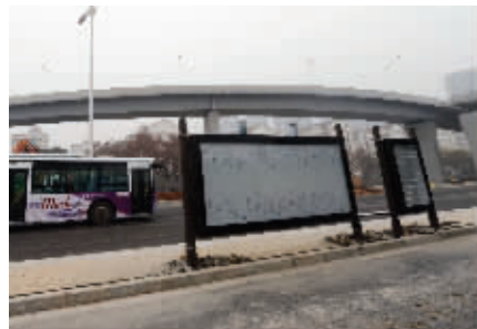
江东路正在建设中的公交站台
