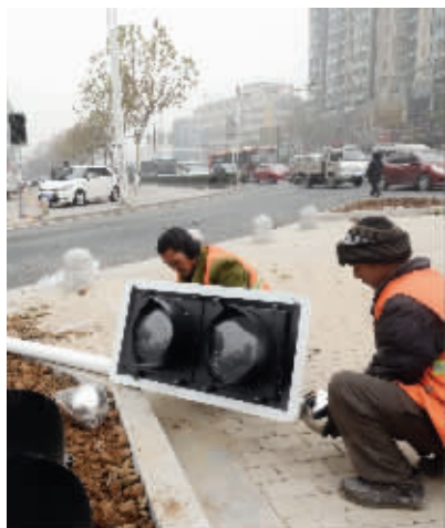
江东路上,工人正在安装信号灯
