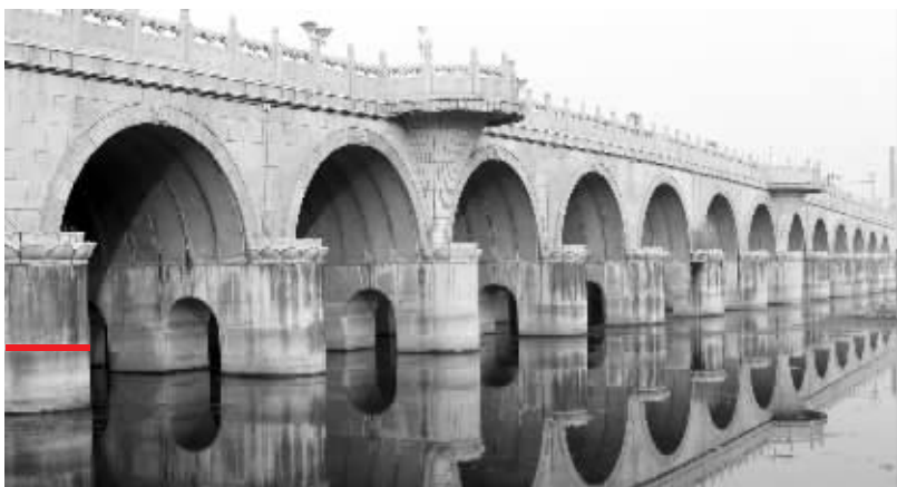
花神渡桥墩上可看出水位明显下降(红线为以前水位) 现代快报见习记者 邱稚真 摄
