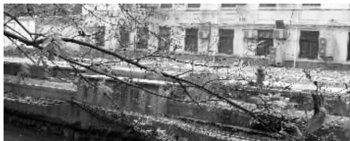
33号楼已被拆掉了 报料人供图
