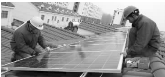
工人们正在屋顶安装太阳能光板 张开虎 摄
