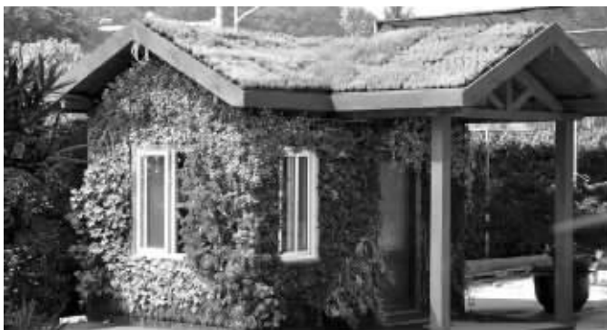
屋顶和墙面都能长满绿色植物 资料图片
