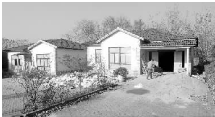
农庄里的房子正在装修
