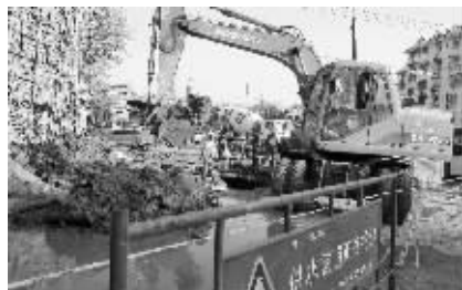
抢修漏水的水管 现代快报记者 马晶晶 摄
