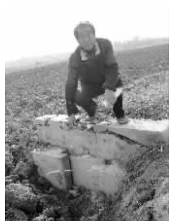
土地重新平整后,小水闸或被破坏,或被土掩埋
