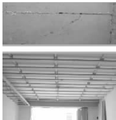
彻底根治开裂、塌落的办法——石膏板满铺吊顶
