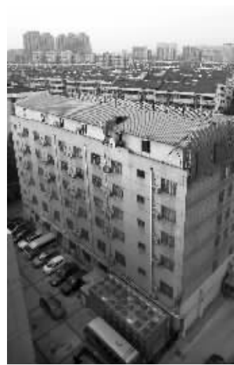
广告牌挡住了楼顶违建 现代快报记者 辛一摄
