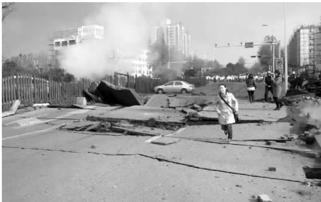
街上大大小小的裂缝很多,场景就像灾难片一样
