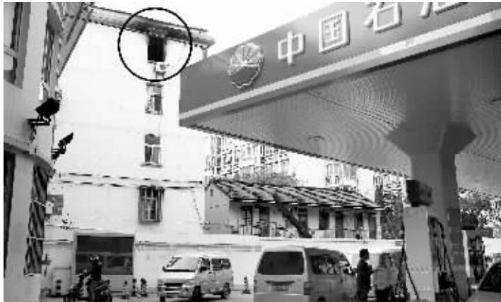
紧邻加油站的居民家(画圈处)发生火情 现代快报记者 辛一 摄
