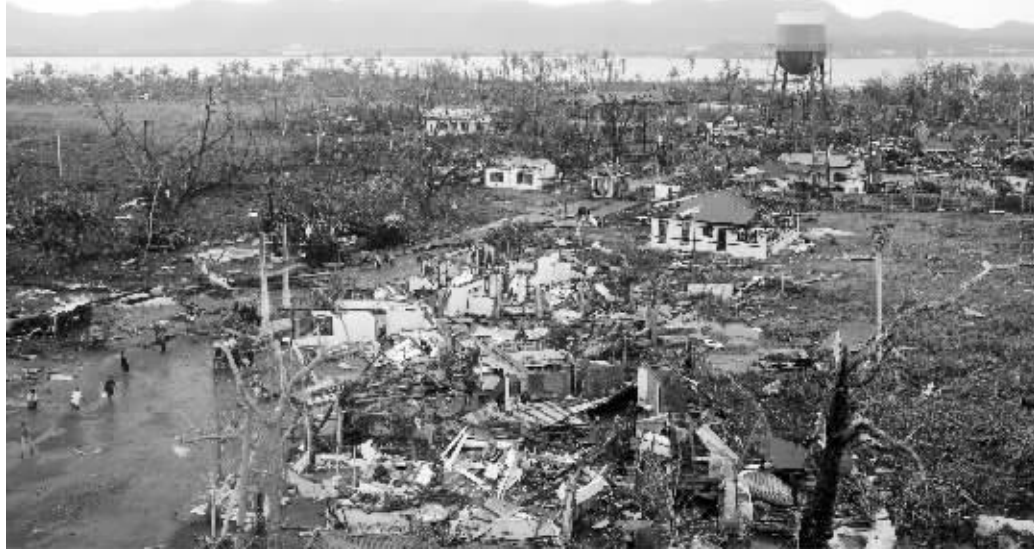
11月9日拍摄的台风“海燕”过后的菲律宾莱特岛塔克洛班市被毁坏的建筑物 新华社/法新
