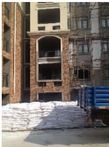
香榴湾小区工地上仍在施工 现代快报记者 孙玉春 摄
