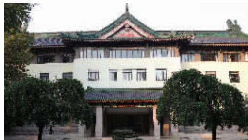
南京市政府办公楼
