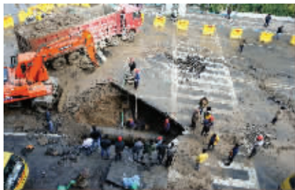
水管爆裂抢修现场
