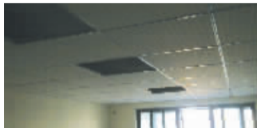
办公楼常见的石棉吊顶已见雏形
