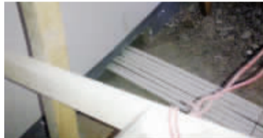
房间墙壁被打通,便于管线穿过
