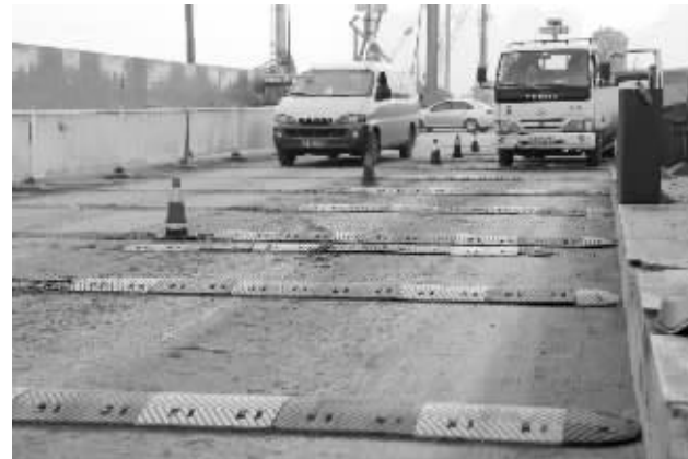
这些减速带,昨天大部分已被拆除 现代快报见习记者 邱稚真 摄
