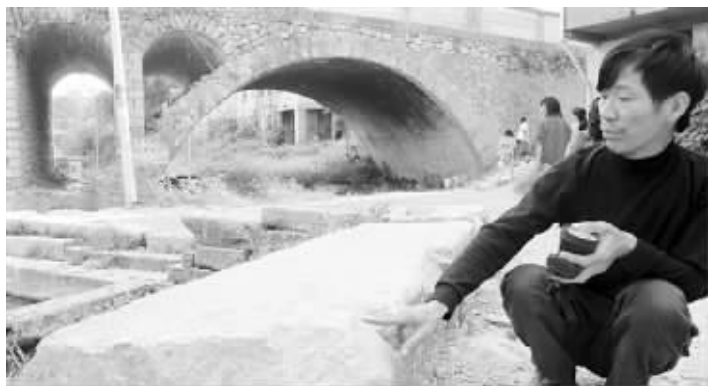
八仙板桥已被拆成石墩
