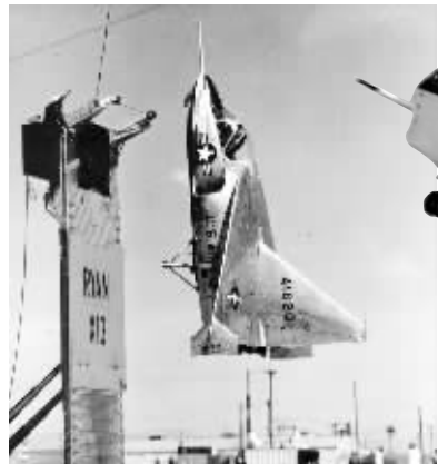
“瑞安 X-13”飞机,1955年由瑞安航空公司为美国空军制造,能够垂直起飞、飞行、降落
