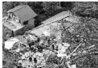
建筑物受损严重
