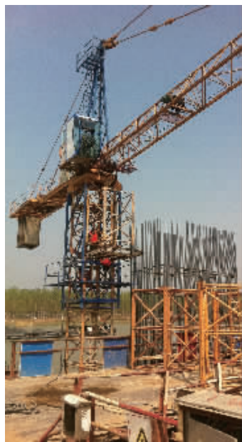
张楼运河特大桥主墩施工
