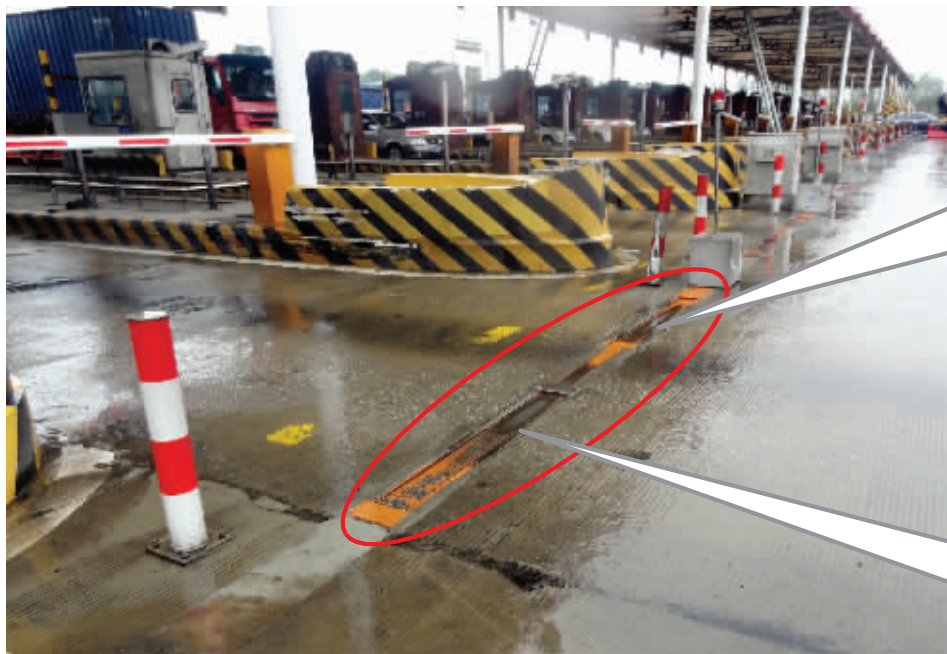
南京二桥收费站道口的破胎器
