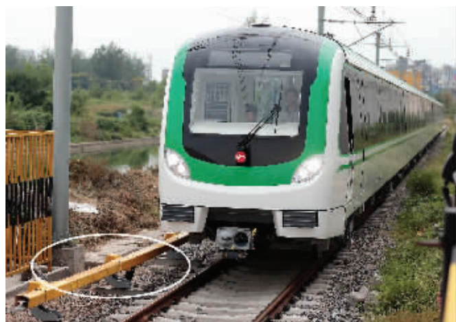
头上不再顶着“小辫子”,供电接触网安在与路轨并行的第三条轨道上(画圈处) 顾炜 摄
