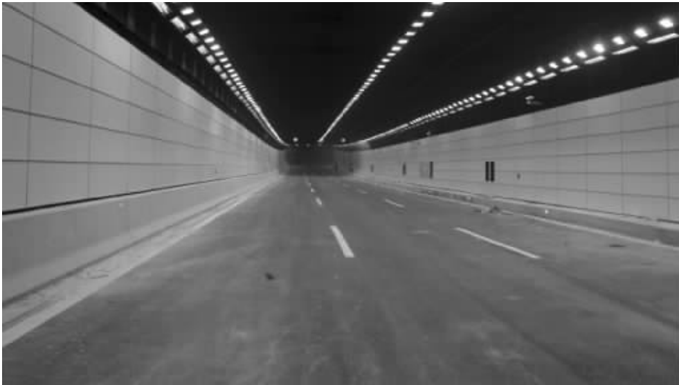
隧道内部单向三车道,光线充足 照片均由陆文杰摄
