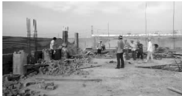
新区城管依法拆除硕放千余平米违法建设
