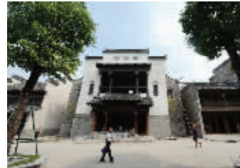
德云社正在进行内部装修
