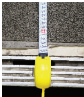
电梯轿底宽约1.45米
