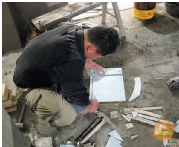
瓷砖在铺贴过程中会出现不同程度的损耗
