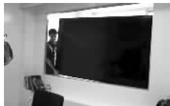
工作人员将超高清屏幕装在墙壁上
