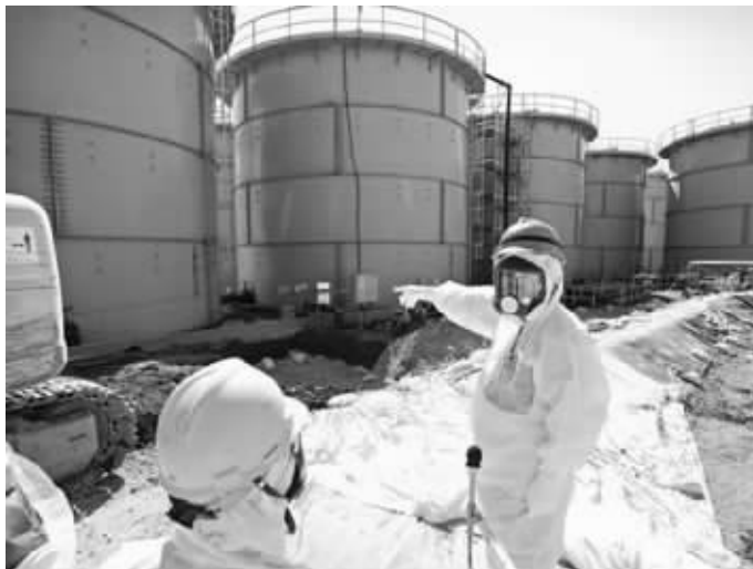
用来冷却福岛核电站4号反应堆的储水罐泄漏了大量高放射性污水
