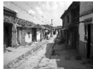
铺管道后的“龙脊街” 鞠永平 摄
