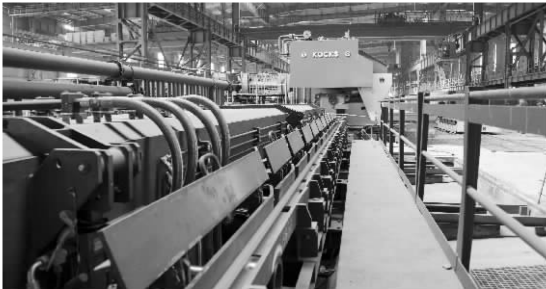
投入上亿元从德国引进的考克斯轧机正在生产优质合金管坯 陈明 摄
