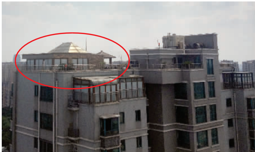
武进一高档小区楼顶建起疑似“空中别墅” 现代快报记者 葛小林 摄
