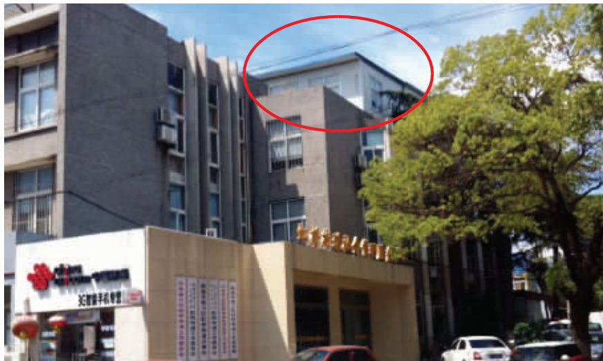
建在办事处楼顶上的违章建筑 现代快报记者 陈莹 摄
