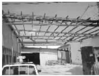
清除违建现场
