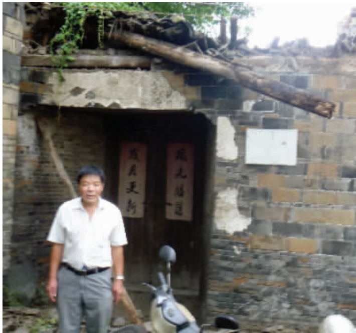
解祥洪站在倒塌的“榜眼门”前 鞠永平 摄
