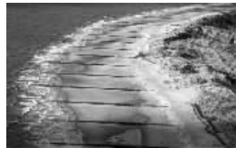
荷兰一处建有固沙装置的沙滩
