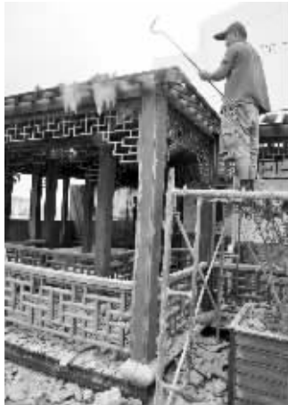
楼顶违建已经开始拆除 现代快报记者 何寅平 摄
