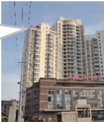
坐落于大楼楼顶 现代快报记者 何真平 摄
