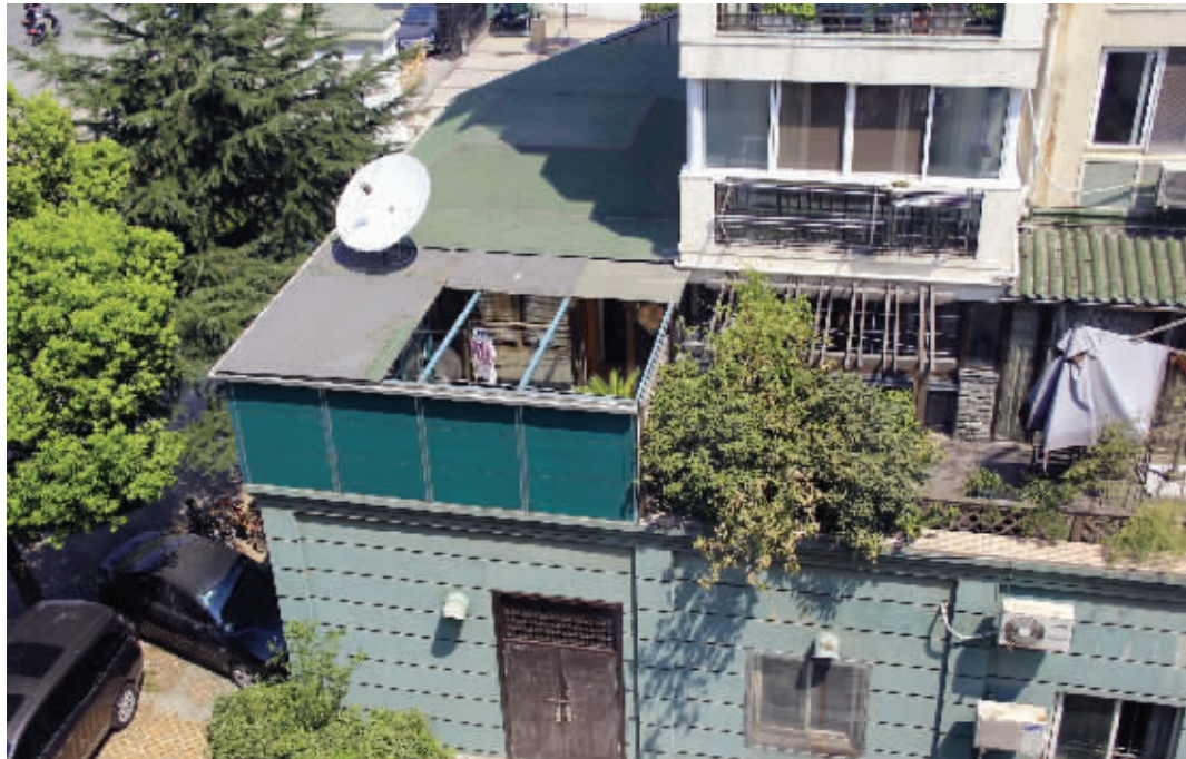
此处搭在配电房顶上的违建与楼下墙体色调一致,不易发现 现代快报见习记者 徐洋 摄
