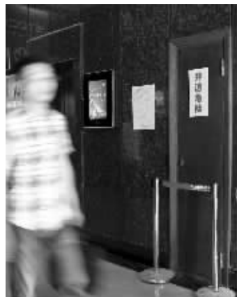
电梯井门口贴上了“井道危险”警示牌
