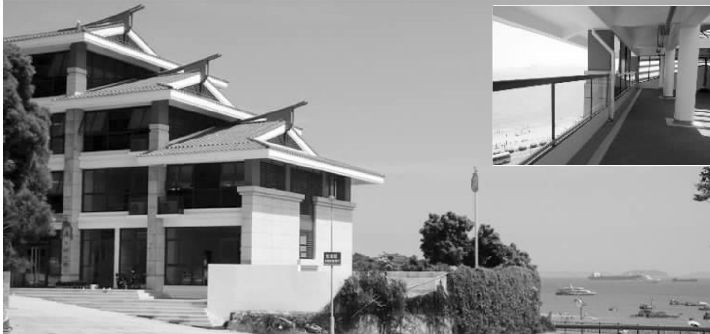
刚刚竣工的厦门大学幼儿园一角
