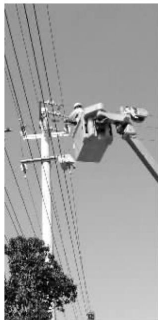
电力师傅站在高空检修10千伏高压线路 实习生温馨摄
